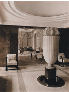
旧朝香宮邸次室・香水塔 1933年竣工時
