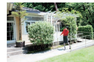
田園調布の家(大川邸)。1925年竣工
