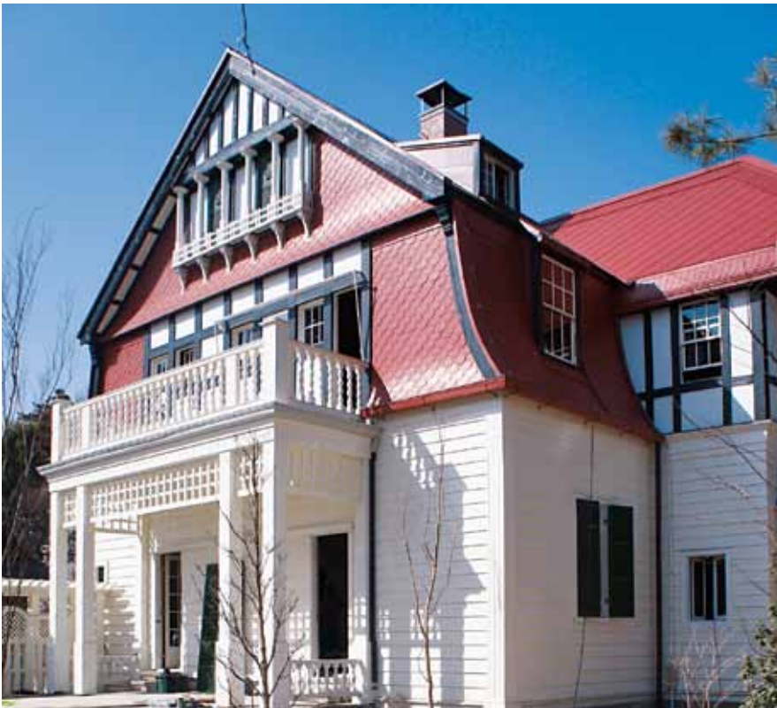
デ・ラランデ邸外観 Exterior of House of George de Lalande
