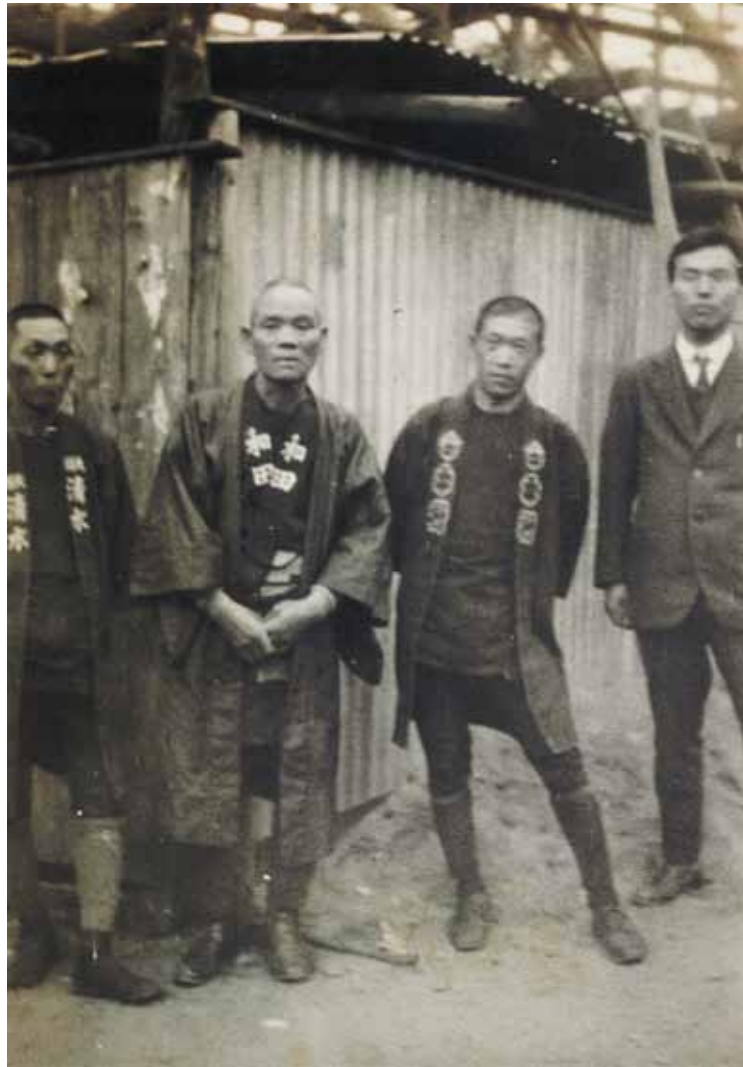
小出邸工事中の大工と建築家・堀口捨己 1925年頃 写真所蔵: 大山みどり
