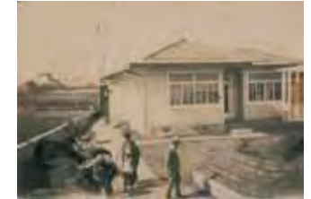
工事中の大川邸 1925年頃 写真所蔵: 大川均 Okawa House, under construction, c. 1925. Photo courtesy: Hitoshi Okawa
