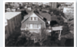
解体前のデ・ラランデ邸 (旧三島邸)
