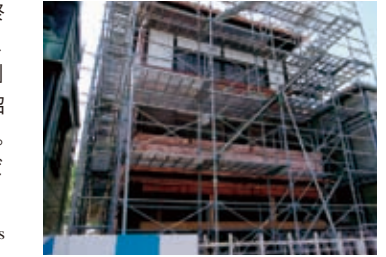
建設中の大和屋
