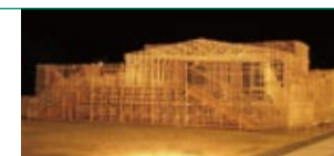
日比野克彦アートプロジェクト「ホーム→アンド←アウェー」方式 尾鷲ヒノキ舞台プロジェクト [But-a-I] (2008-2009年) 三重県立根野吉道センター
