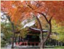
旧自証院霊屋 東京都指定有形文化財
