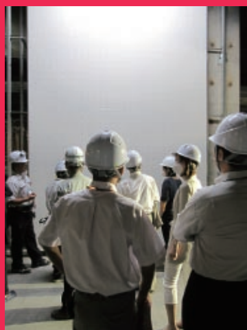
改修工事現場で確認作業中の美術館スタッフ
